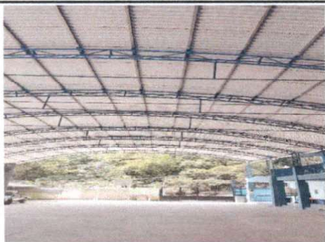
Foto 1: Cambio de lámina, por lámina troquelada aluzinc calibre 26 el patio del establecimiento.
