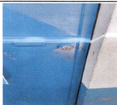
Foto 6: Mantenimiento a estructura (lijado, cambio de tubo, cepillado, sujeciones, aplicación de pintura de la puerta del aula 3 del modulo 1
