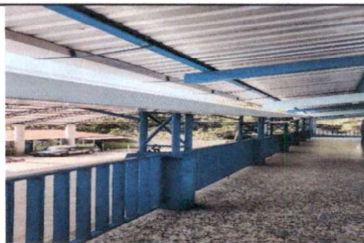
Foto 4: Canal y bajada de agua pluvial en el modulo 3.
