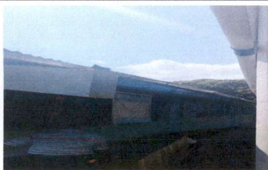
Foto 5: Sustitución de canal de metal en el modulo 1 del establecimiento.
